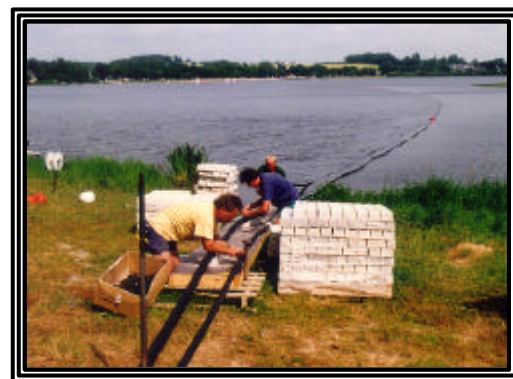
Mise en place des lignes de bullage
